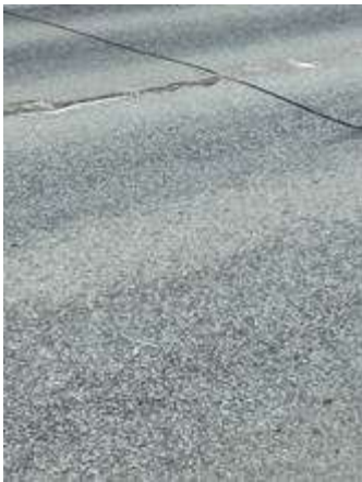
Photo 3. Bridge across Vääna river
